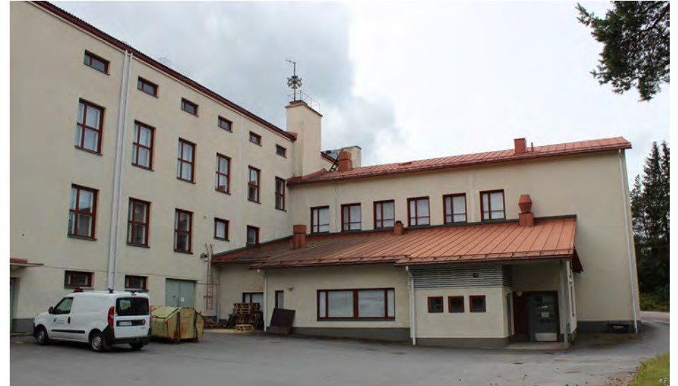
Yläkuvassa Keskuskoulun voimistelusiipi ja sen yhteyteen rakennettu pulpettikattoinen ruokalan laajennus vuodelta 2001. Kuvassa vasemmalla sisäänkäynti oppilaiden wc-tiloihin. Kuva on otettu pohjoisesta vuonna 2019.
