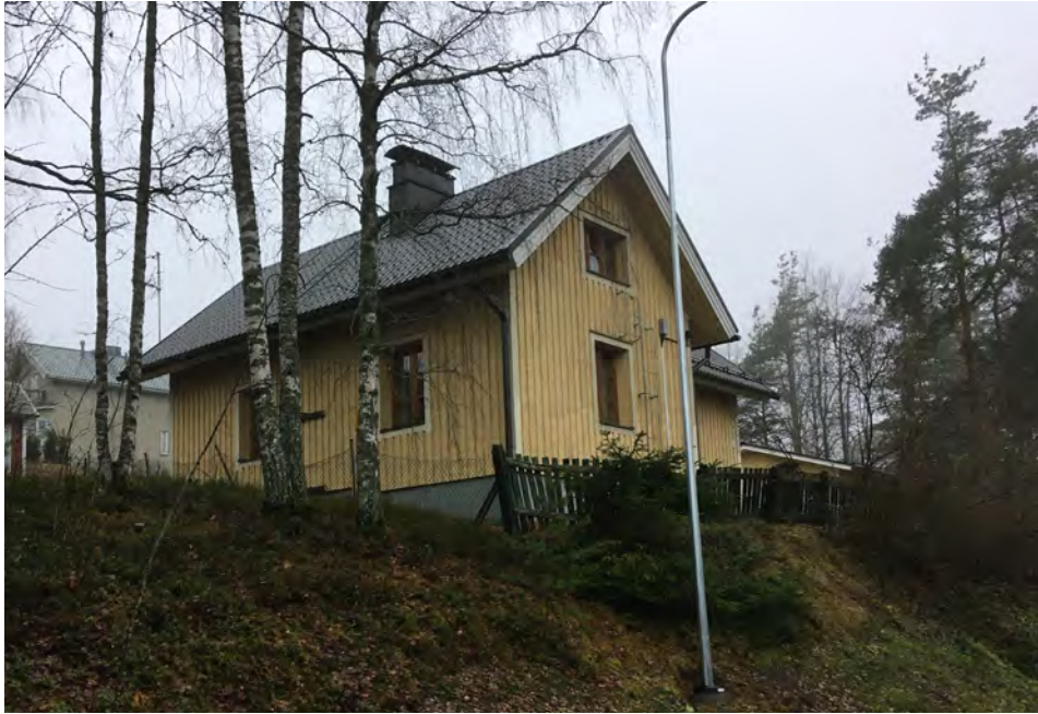
Kesolantie 26 edustaa ulkohahmonsa perusteella 1930-luvun asuinrakentamista.
