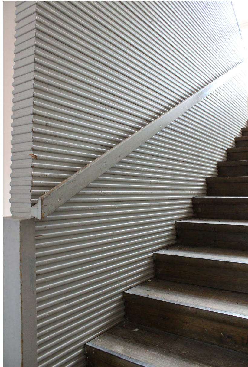
Koulusiiven porrashuoneen portaikko johtaa ullakkokerrokseen.
