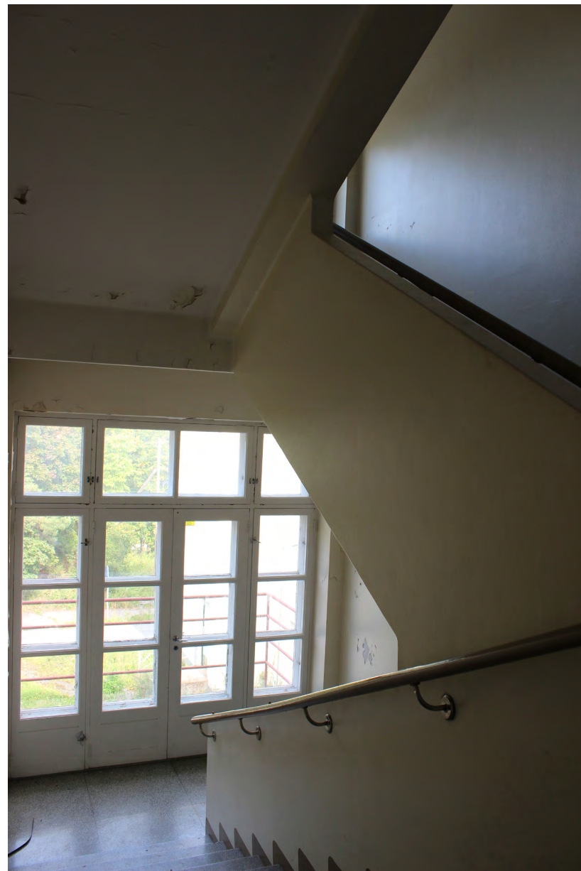
Kuvassa asuinsiiven porrashuone ja tuuletusparvekkeelle johtava parvekeovi.
