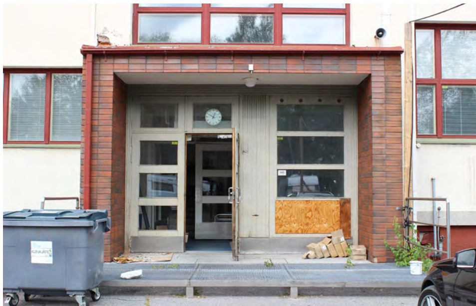
Kuvassa kaakkoisjulkisivun pääsisäänkäynti vuonna 2019.
